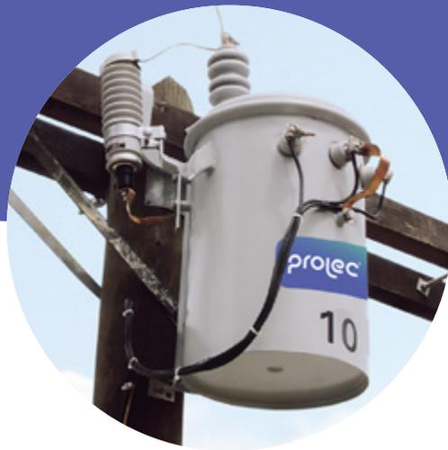
Terminal de alta tensión de porcelana (fusible de expulsión montado internamente en aparatos tipo autoprotectidos)
